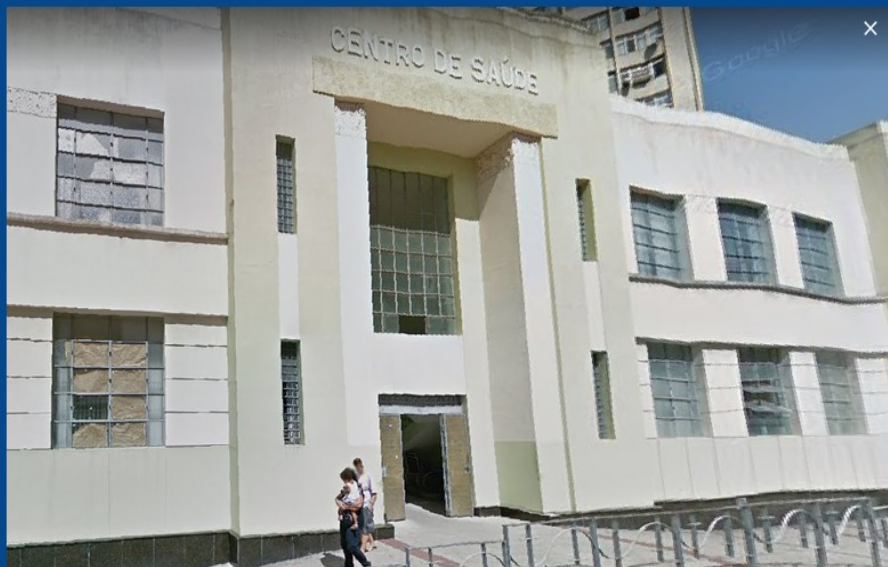
Entrada (Fonte: Google Street View)
