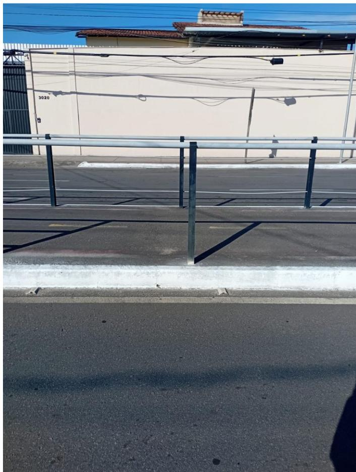
No “guarda rail” em questão, neste trecho registrado na imagem falta colunas de sustentação e outros ferros de proteção. Logo toda estrutura está em falta, o que coloca em risco a segurança de quem passa pela via.
