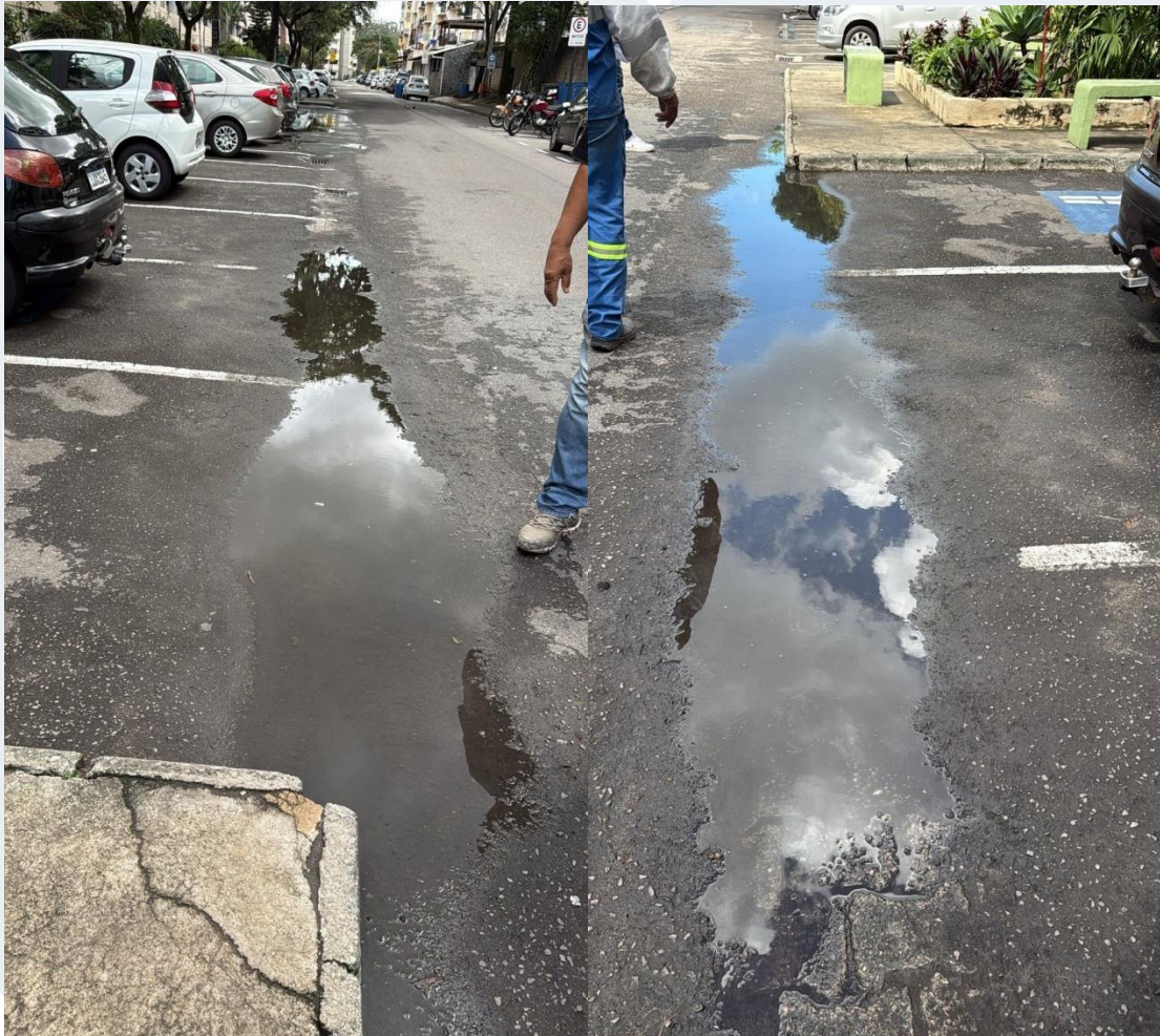
Foto 1: Local indicado para construção de boca de lobo.
