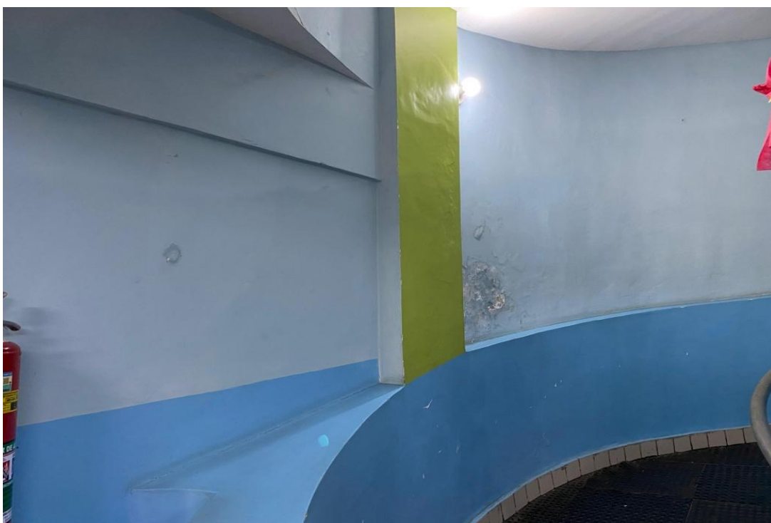
Infiltração próxima à elementos estruturais (pilar e viga) e instalações elétricas.
