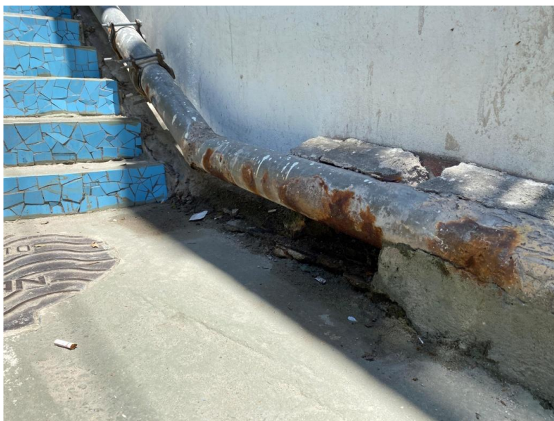
Ponto mais crítico de vazamento.
