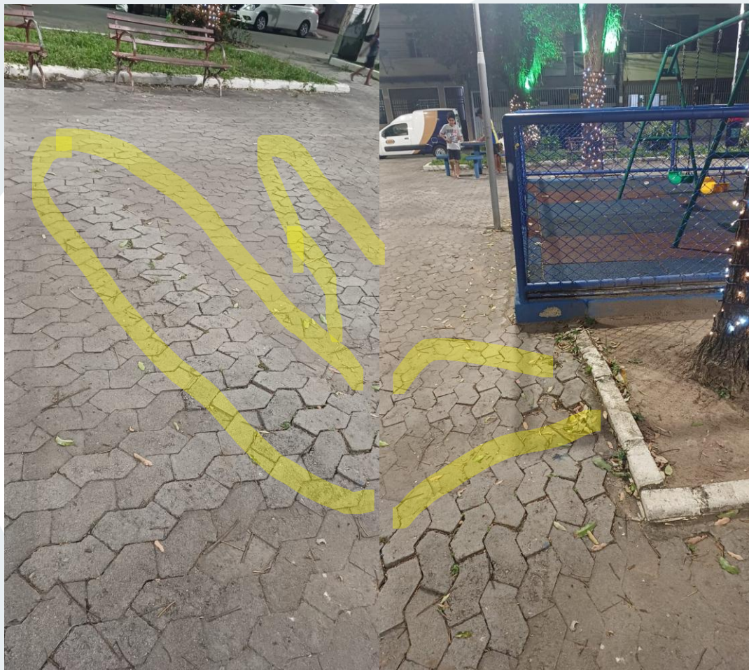
Foto 1: Pavimentação com elevação devido crescimento de raízes de árvore.
