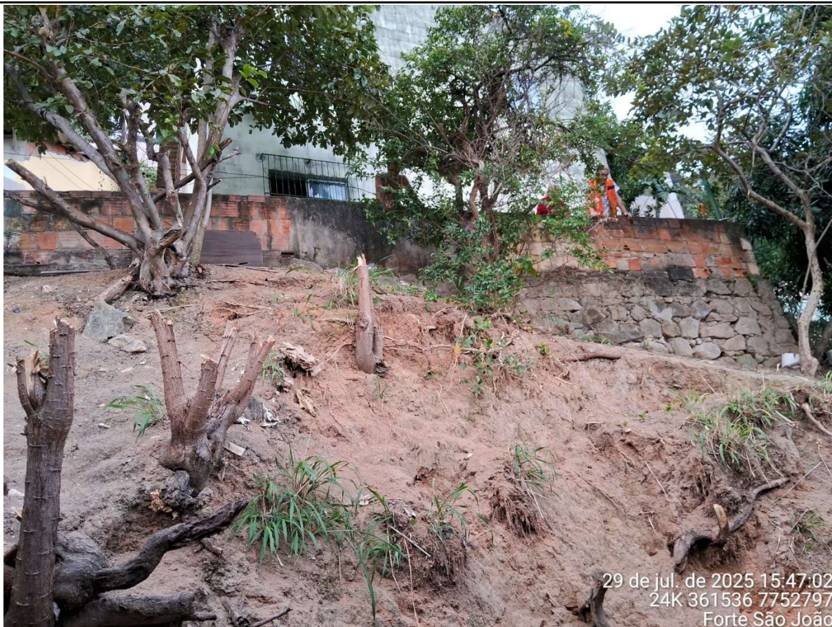
Imagem 12. Processo erosivo observado na face do talude. Acima, vista parcial do imóvel do Sr. Antônio Borges.
