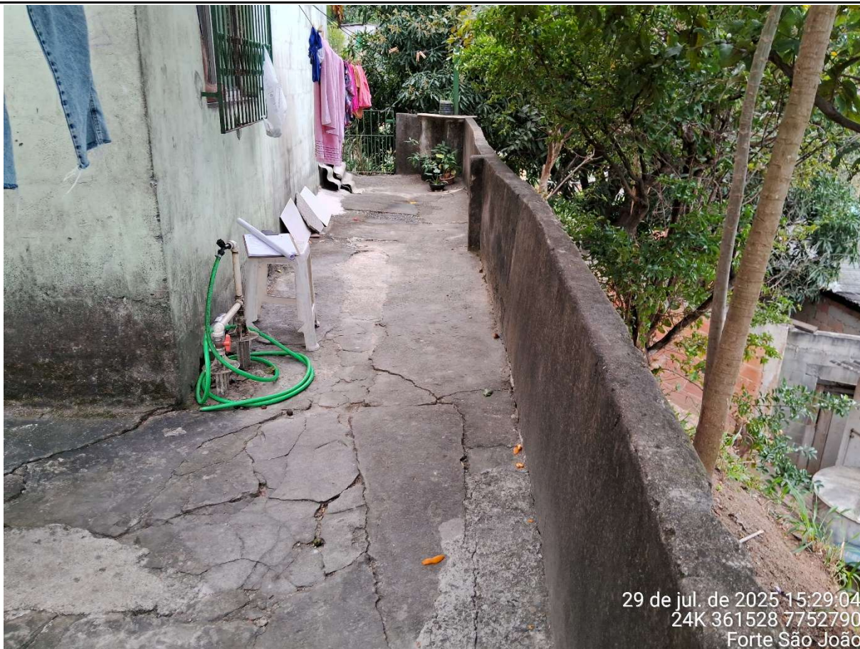
Imagem 2. Área de serviço do imóvel do Sr. Antônio Gatti na cota superior. Pode-se notar deformações significativas no muro com desaprumo considerável.
