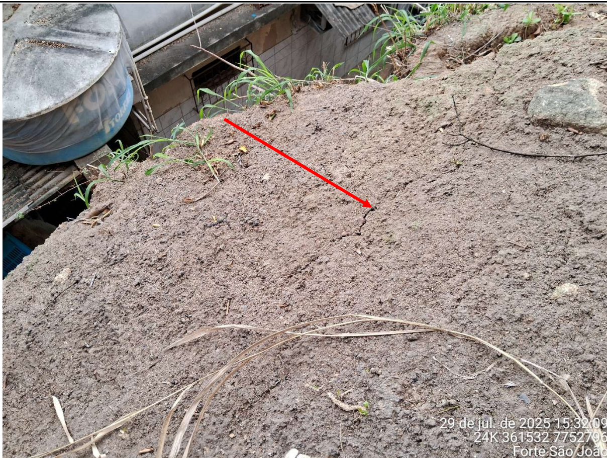
Imagem 10. Trinca observada na face do talude.
