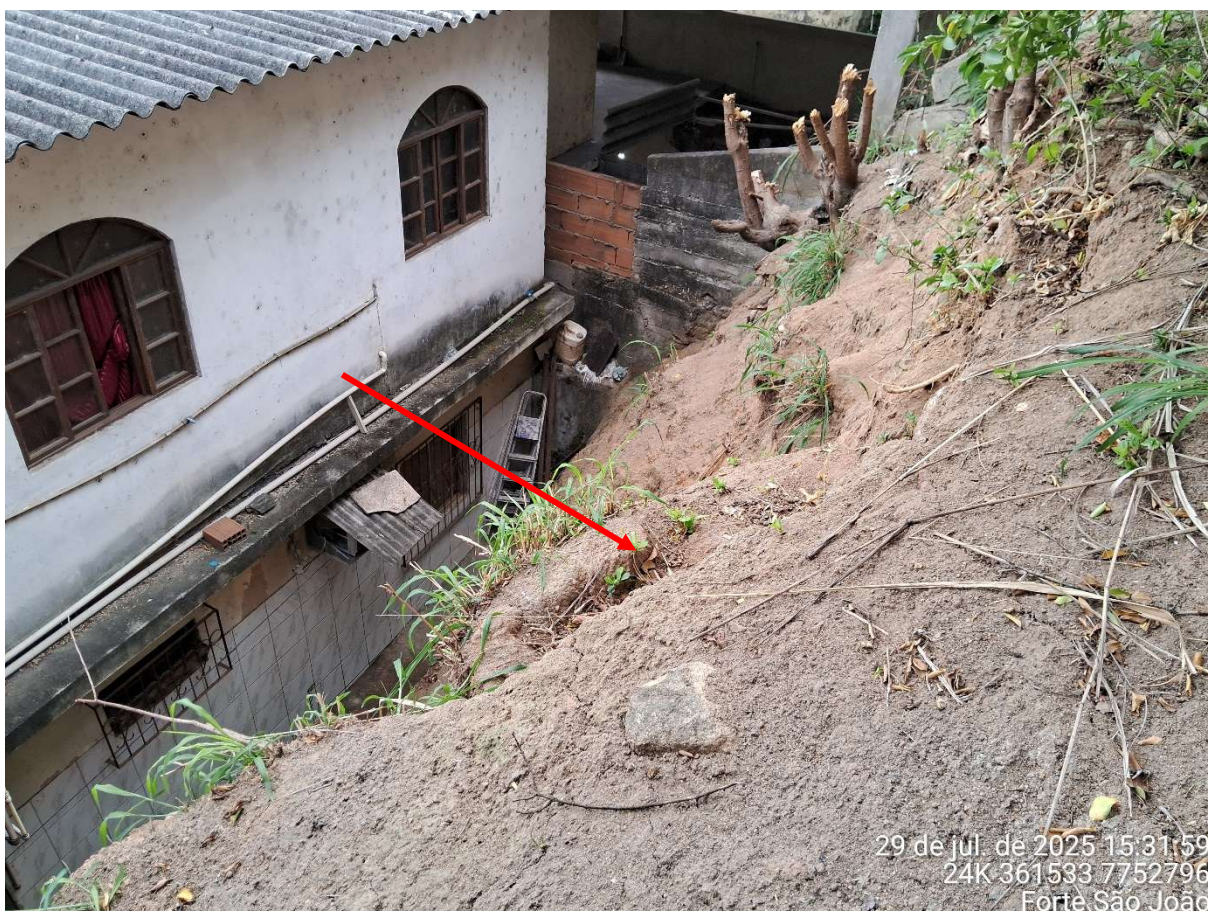
Imagem 9. Degrau de abatimento e erosão observados no talude. À esquerda, fundos do imóvel da Sra. Camila Borges.
