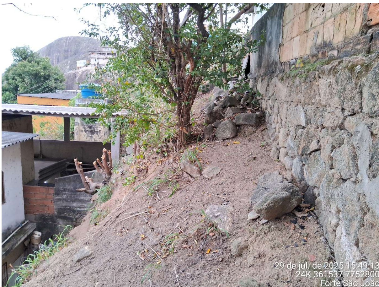
Imagem 7. Crista do talude onde se observam blocos e fragmentos de rocha de pequeno porte, soltos, dispersos e ou concentrados.
