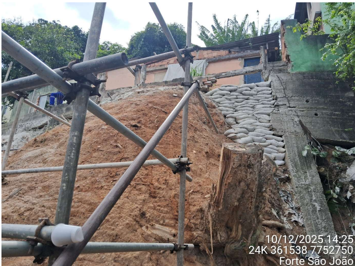
Imagem 07 – Vista para porção do talude onde está sendo realizada obras de contenção.
