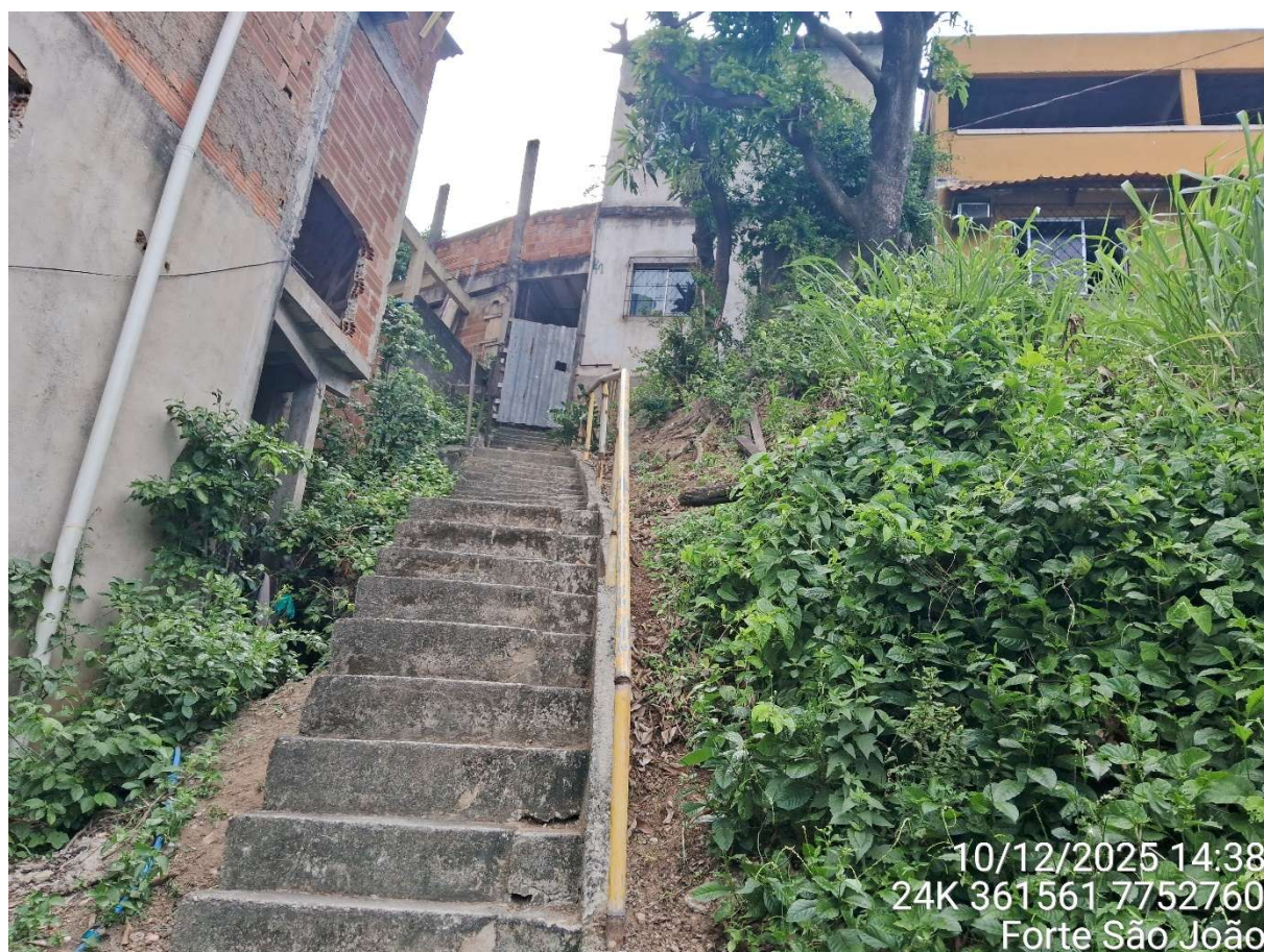
Imagem 01 – Vista para fachada do imóvel.
