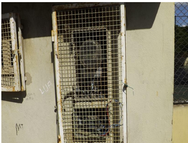
FIAÇÃO EXPOSTA NA CAIXA DE ENERGIA
