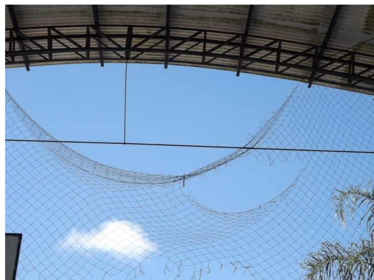
REDE DE PROTEÇÃO RASGADA
