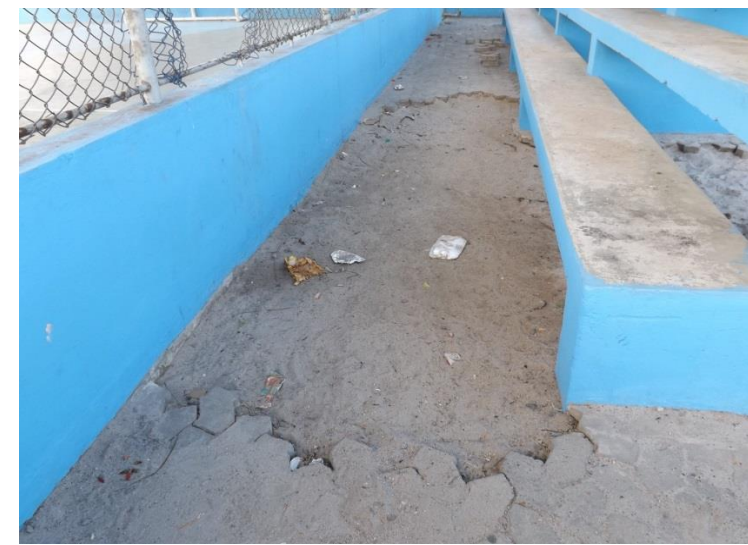
PISO NO ENTORNO DA ARQUIBANCADA COM BURACOS
