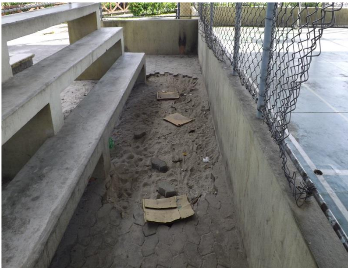
PISO NO ENTORNO DA ARQUIBANCADA COM BURACOS
