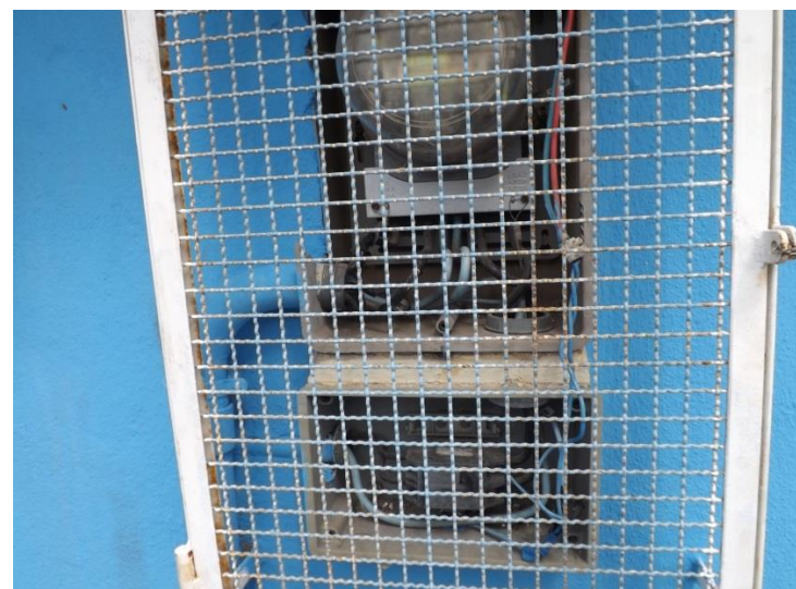
FIAÇÃO EXPOSTA NA CAIXA DE ENERGIA
