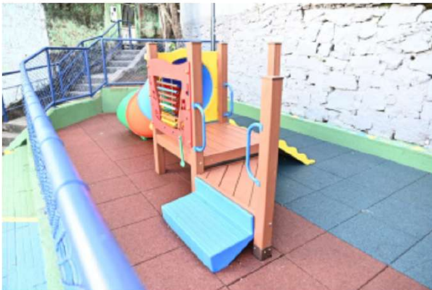
O Parque Kids foi adaptado com uma nova pavimentação, que possibilitou a instalação de pisos emborrachados, de mais fácil higienização e manutenção, com tecnologia de absorção de impacto. Foto: Marcos Salles/PMV
