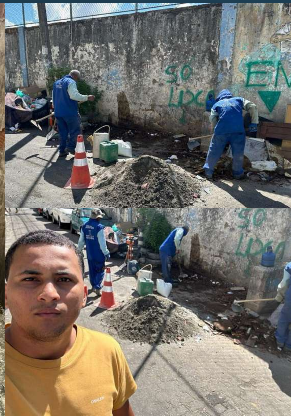
MANUTENÇÃO NA REDE DE ESGOTO
