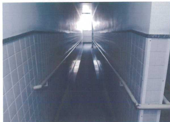
RAMPA DE ACESSO AO 2º ANDAR
