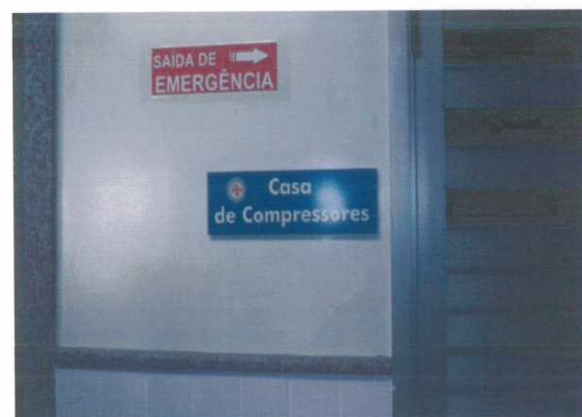
CASA DE COMPRESSORES
