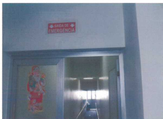
SAÍDA DE EMERGÊNCIA
