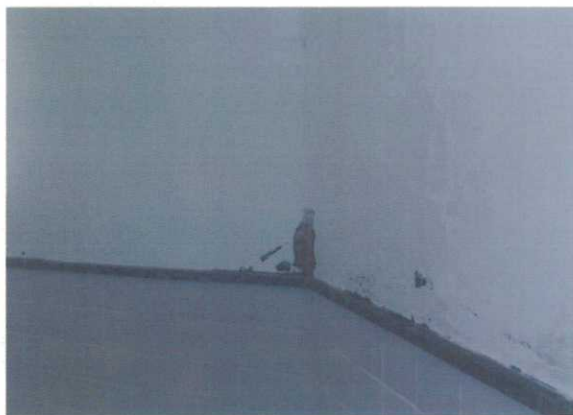
PAREDE DO CORREDOR DE ACESSO
