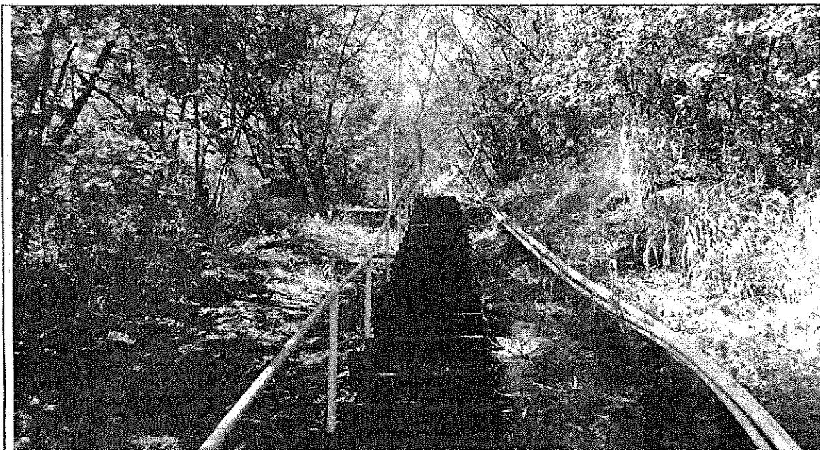
Fig 03 – Vista do acesso principal (escadaria). Vegetação exótica nos flancos.
