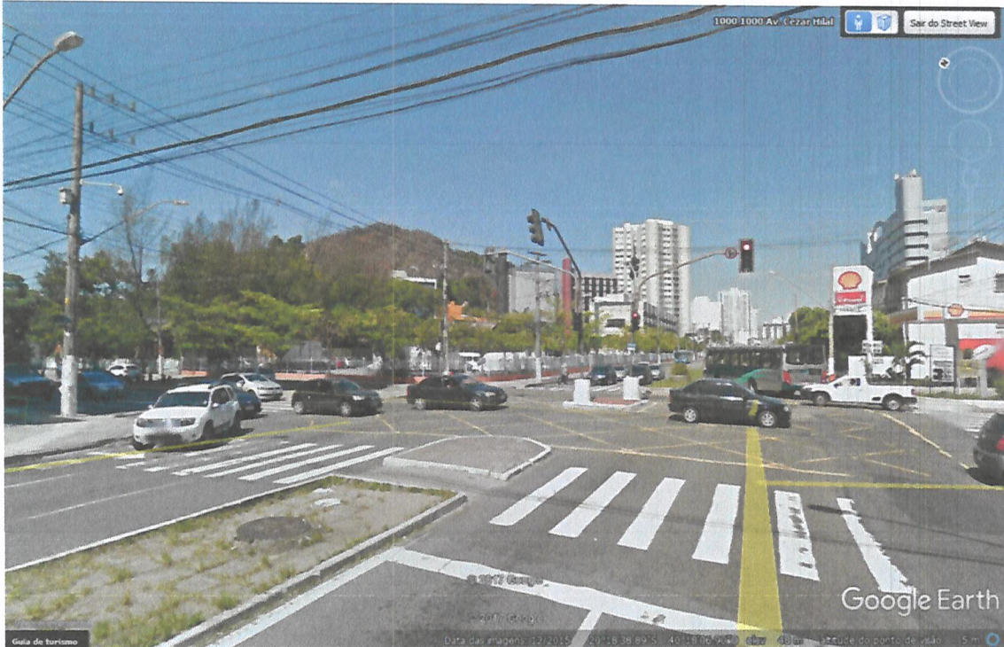
Foto 01 – Vista da Avenida Cesar Hilal antes do cruzamento com a Avenida Leitão da Silva, observando em direção ao Morro do Itapenambi.
