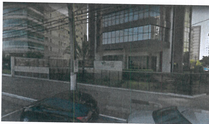
Edifício com piscina no afastamento frontal - Mata da Praia – Vitória
