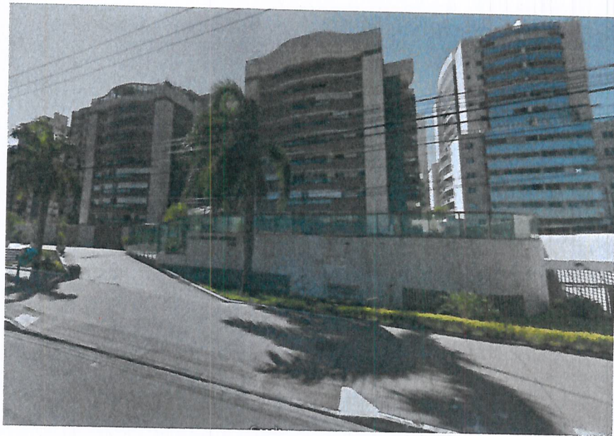
Edifício com piscina no afastamento frontal - Mata da Praia – Vitória
