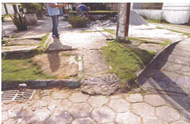
RAMPA DE ACESSO À PRAÇA
