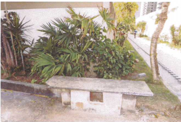
BANCO DA PRAÇA - DANIFICADO
