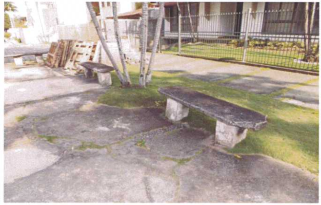
BANCOS DA PRAÇA - DANIFICADOS
