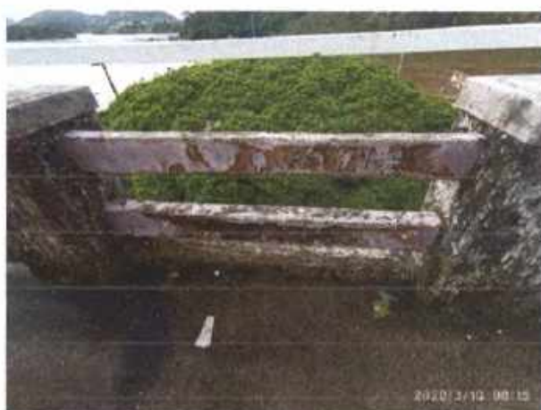
Figura 43 – Corrimão em concreto
