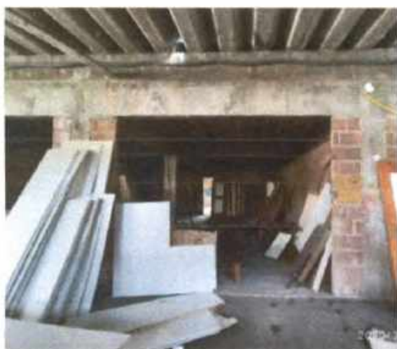
Figura 33 – Vista sala inacabada
