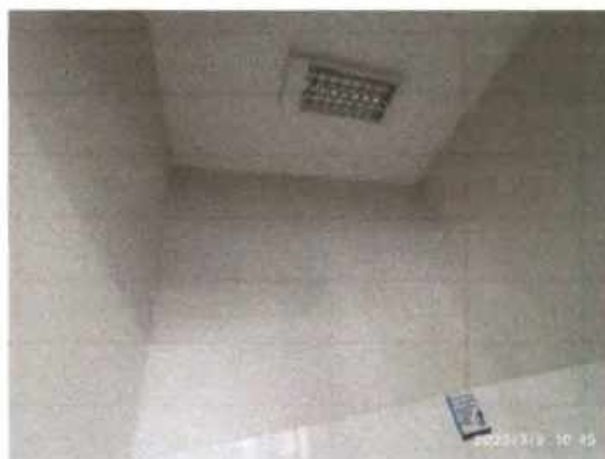
Figura 16 - Teto do banheiro - pavimento 1
