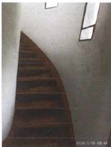
Figura 108 – Acesso andar intermediário
