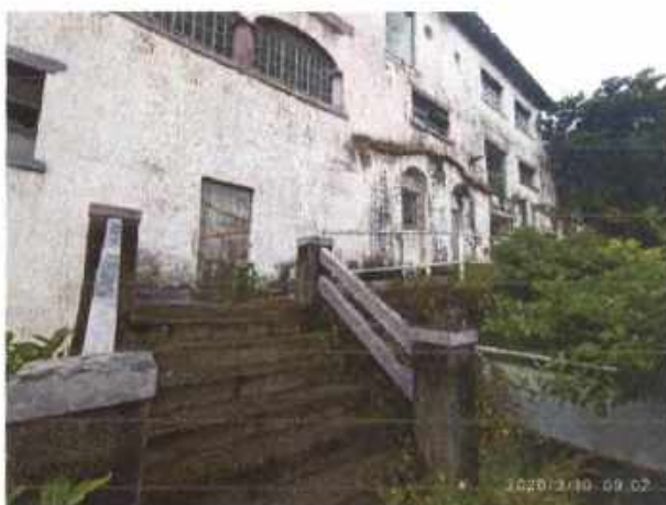
Figura 127 – Escada acesso externo
