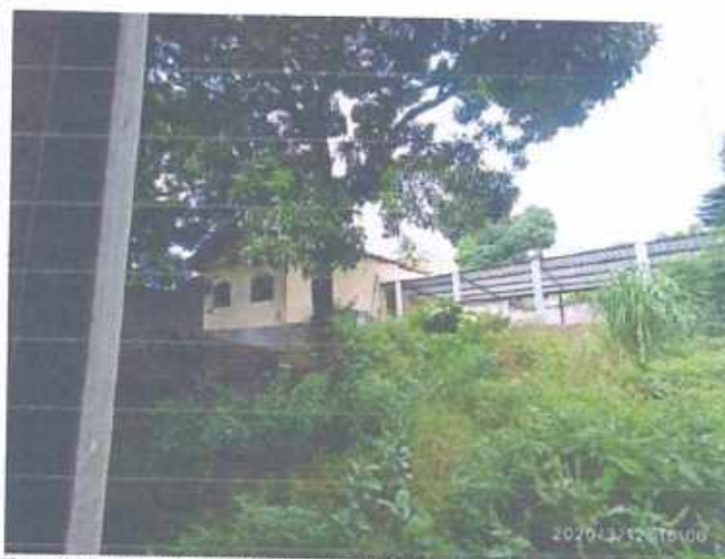
Figura 42 – Vista fundos / edificação dividida
