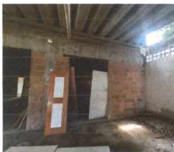
Figura 35 – Vista sala inacabada
