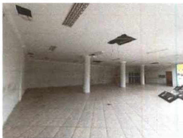
Figura 12 – Vista interna - pavimento 1
