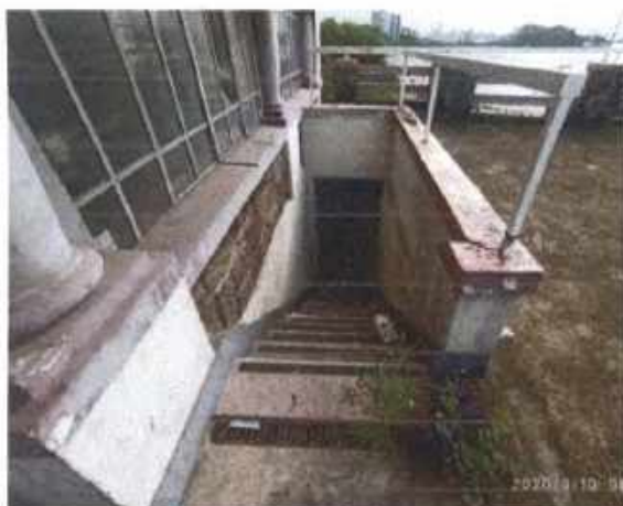
Figura 38 – Acesso andar intermediário
