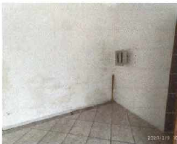
Figura 13 - Vista interna - pavimento 1
