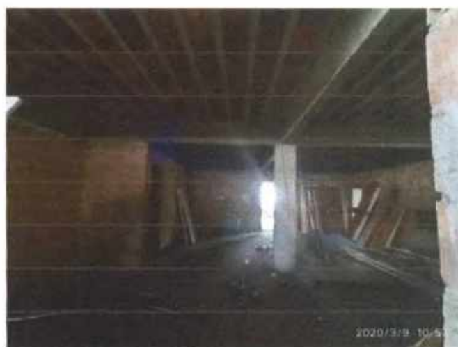
Figura 34 – Vista sala inacabada
