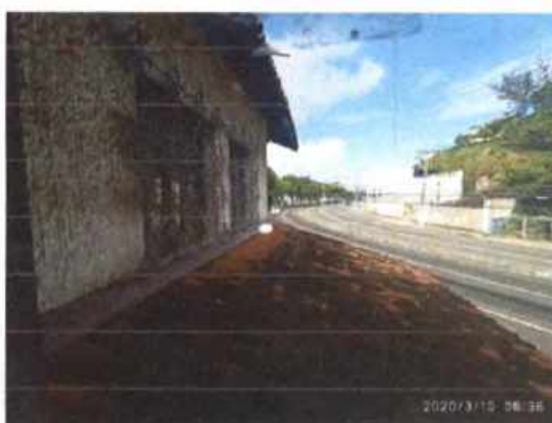
Figura 89 – Vista parte da cobertura
