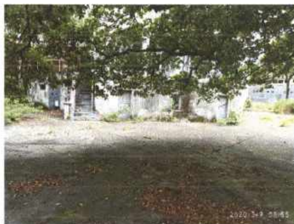
Figura 16 – Vista externa - piso cimentado
