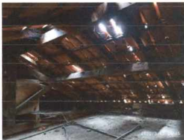
Figura 105 – Vista interna telhado
