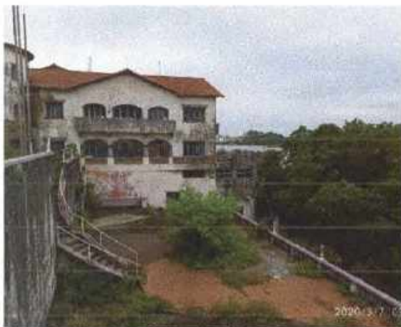
Figura 21 – Vista fachada lateral e pátio
