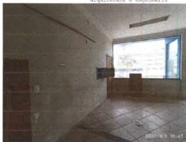
Figura 20 – Vista interna - pavimento 1
