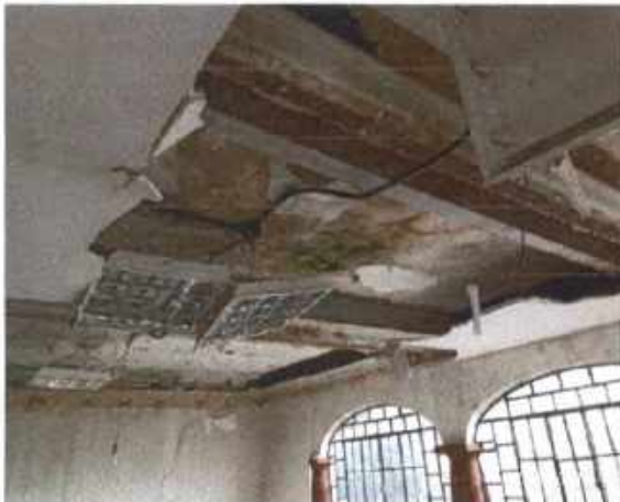
Figura 46 – Teto salão anexo
