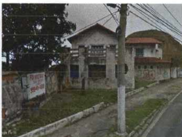
Figura 14 – Fachada 1 - Avenida Vitória
