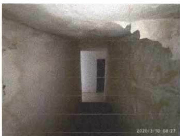
Figura 61 – Escada - acesso à o copa/cozinha
