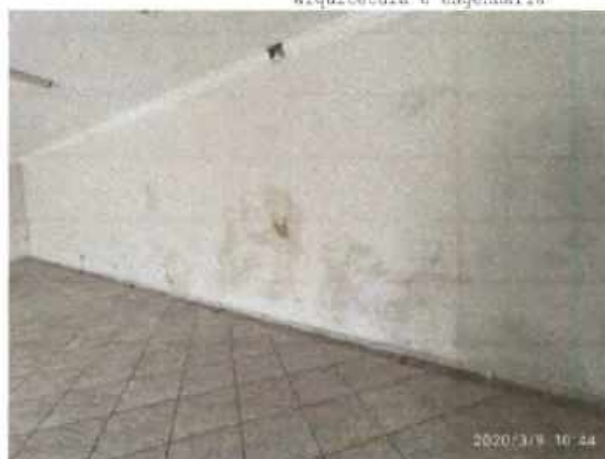
Figura 14 - Vista interna - pavimento 1
