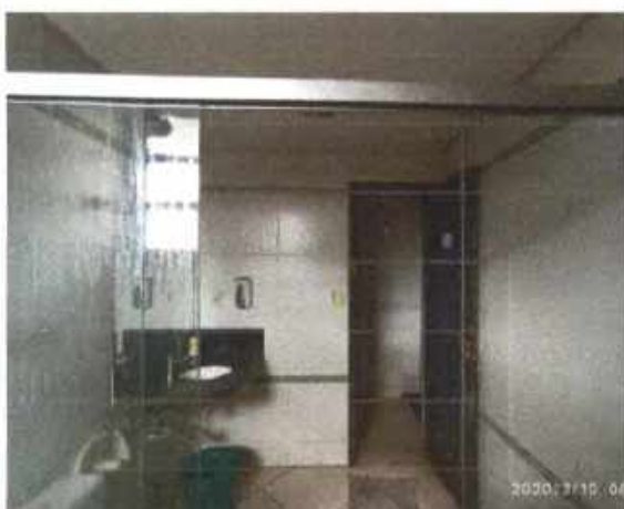
Figura 64 – Banheiro em funcionamento
