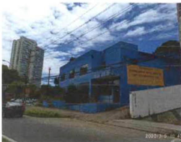
Figura 7 – Fachada 01 – Av. Carlos Moreira Lima
