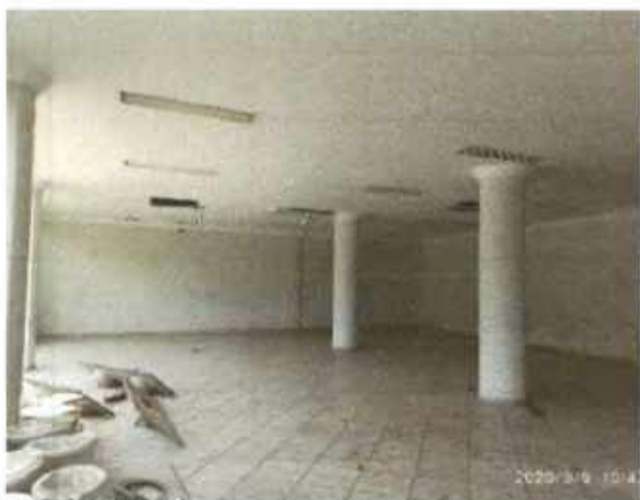
Figura 11 – Vista interna - pavimento 1
