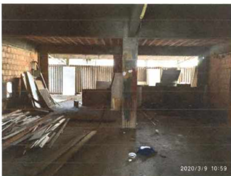
Figura 4 – Pavimento 2 – área inacabada
