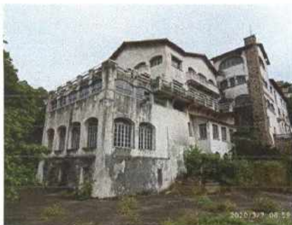
Figura 15 – Fachada 2 - Avenida Mal Mascarenhas de Moraes
