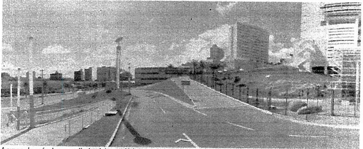
Acesso de veículos a partir de sistema viário complementar, paralelo à Av. Nª Sª da Penha Fonte: Google Maps, acesso em 17/09/2015
