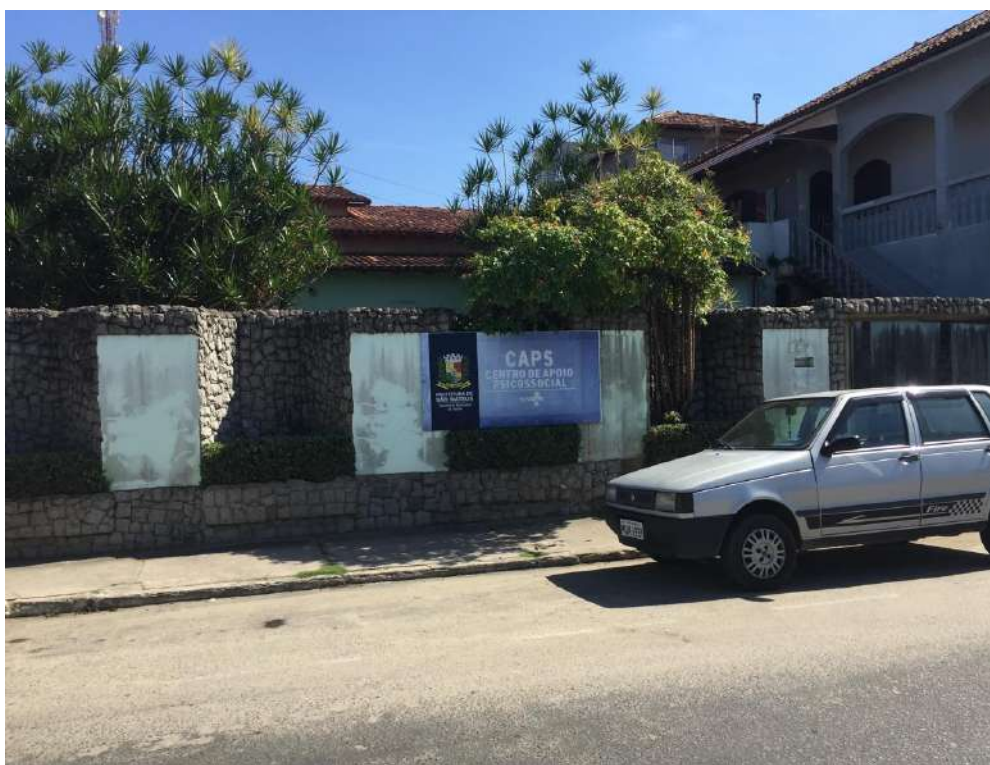
Figura 13 – Fachada do Caps I São Mateus sediado em casa alugada
