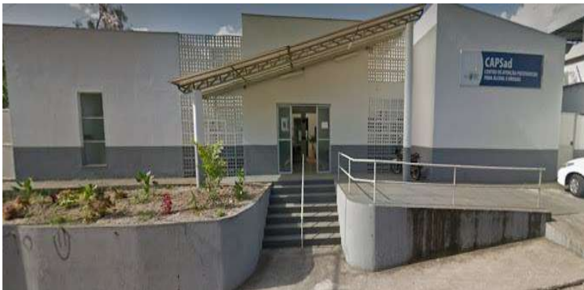
Figura 10 – Fachada do Caps AD Cachoeiro de Itapemirim (foto internet)
